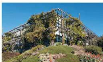
Le bâtiment des services de la mairie de San Francisco, Californie. Les façades sont protégées par pergolas et des brises-soleil câblés qui constituent une structure support en trois dimensions pour les grimpantes.
